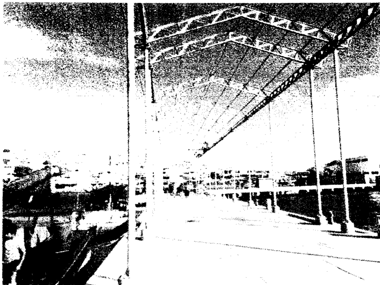
Imagen N° 8 Montaje de viguetas
