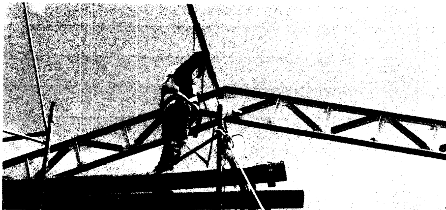
IMAGEN 09 Soldadura de Correa al tijeral 30.
