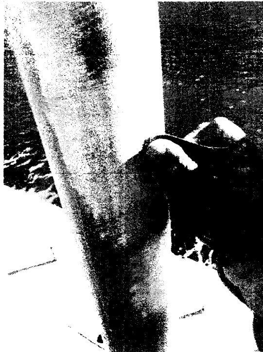
Imagen N° 7 Resanes de pintura en columnas
